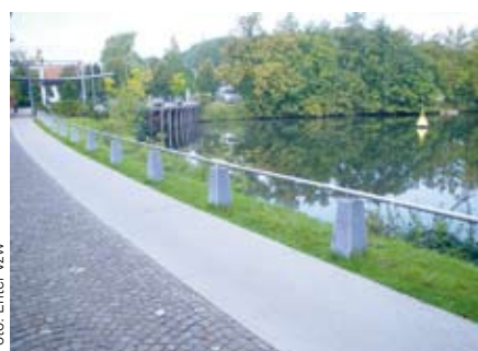
De looproute moet een vlak en rolstoelvast oppervlak hebben met een minimale voeg.
