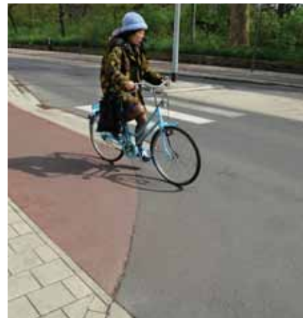
Naadloze aansluiting van fietspad en rijweg.
