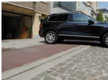
Een constante verhoging van het fietspad in combinatie met een schuin afgekante boordsteen aan een garage-inrit is ideaal.
