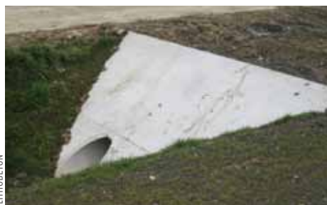
■ Botsvriendelijke kopmuren zijn afgeschuind. Zo komt de klap minder hard aan.
