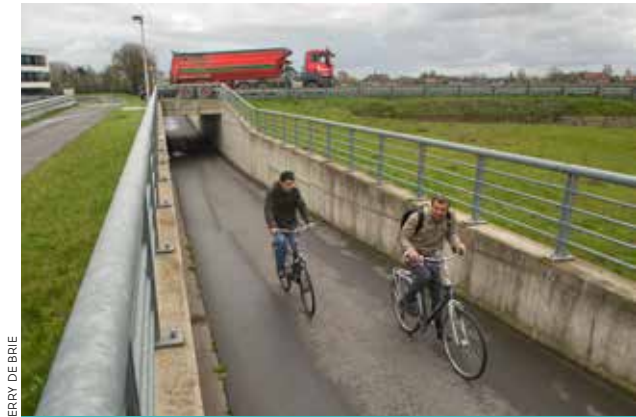
De subsidieprocedure voor fietstunnels zoals in Zwevegem is nu verduidelijkt.
