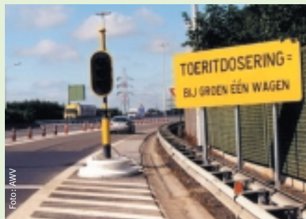
Het rantsoen van 1 wagen per 5 seconden zorgt voor een betere dosering van het verkeer dat de E314 oprijdt in Wilsele-De Vunt.
