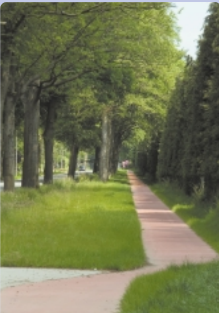
Sinds maart 2005 heeft de gewestweg N115 tussen Brecht en Antwerpen langs beide zijden vrijliggende fietspaden in rood beton. Op deze plaats werd het fietspad extra ver van de rijbaan verwijderd om een dubbele waardenvolle bomenrij te sparen.
