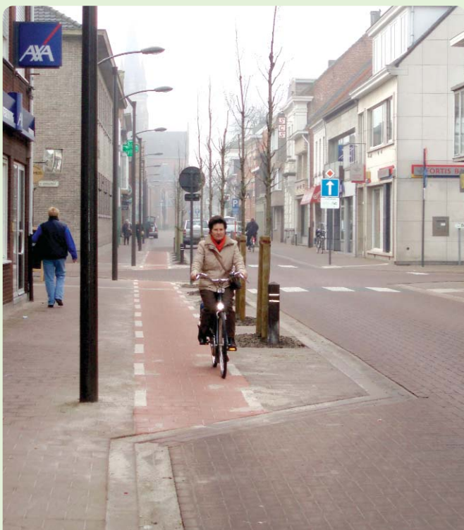
De doortocht in het centrum van Arendonk werd heringericht. Een asverspringing doet auto's trager rijden.
