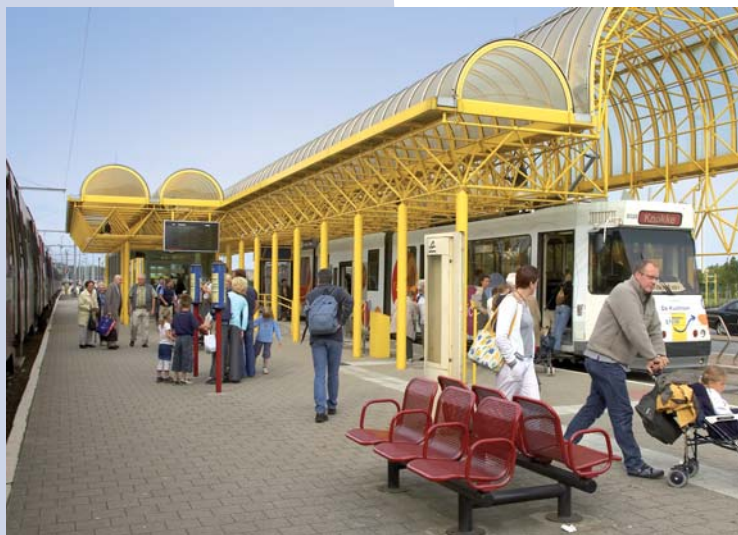
In het station van De Panne komen de trein en de kusttram aan op hetzelfde perron. Vlakbij ligt ook een randparking.
