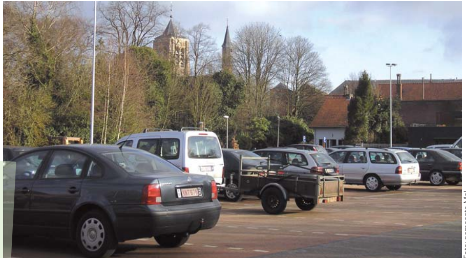
De randparking aan de Rivierstraat is aangelegd in waterdoorlatende materialen. De aanwezige kolken worden enkel gebruikt bij extreme buien.
