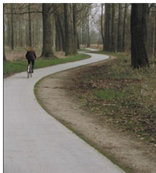
Foto 4.6 Fietspad in cementbetonverharding
