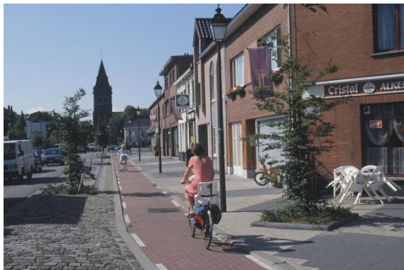
Foto 4.3 Vrijliggend fietspad met veiligheidsmarge en opzichte van de parkeerstrook – Leopoldsburg
