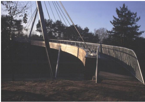
Figuur 4.45 Fietsbrug – Lommel
