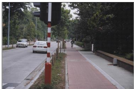
Foto 4.7 Fietspad in bestrating met betonstraatstenen
