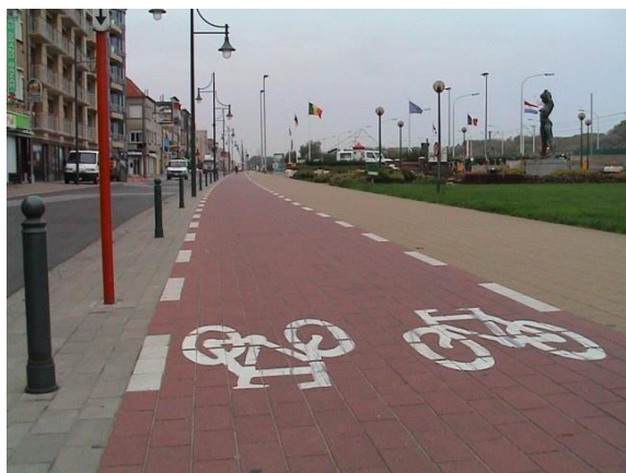
Foto 4.1 Driftweg, Bredene Tweerichtingsfietspad met veiligheidsmarge tegenover rijbaan en palen
