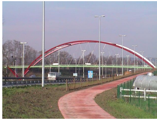
Figuur 4.46 Fietsweg en fietsbrug over E40 - Wetteren
