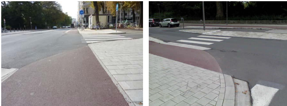
Foto 4.20 Afzagen van de boordstenen en goot zorgt mede voor een comfortabele overgang
