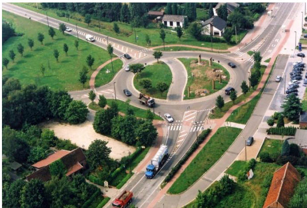
Foto 4.38 Rotonde in verkeersgebied met gescheiden fietspad met fietsers uit de voorrang - Willebroek
