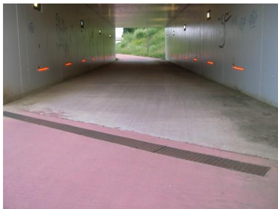
Foto 4.22 Dwarse rooster voor waterafvoer waarvan het bovenvlak perfect aansluit bij het materiaal van het fietspad – de fietser ervaart geen discomfort
