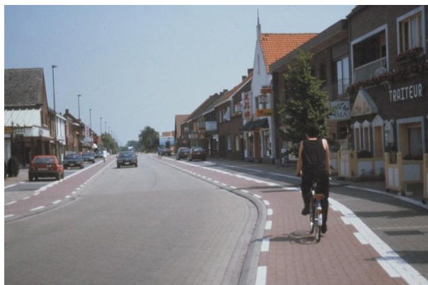
Foto 4.9 Aanliggend fietspad in rode klinkerverharding - Peer
