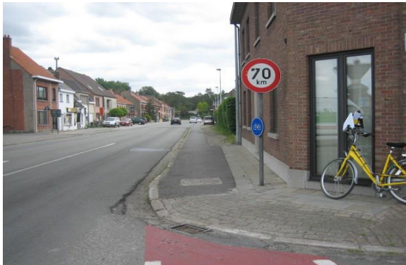
Foto 4.19 Slechte overgang bij oprijden fietspad
