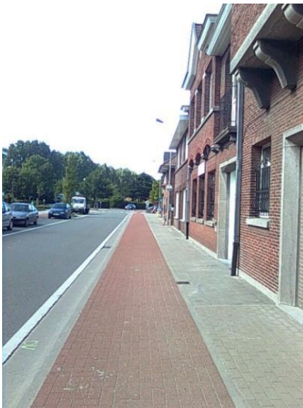
Foto 4.21 Fietspad op niveau doorgetrokken
