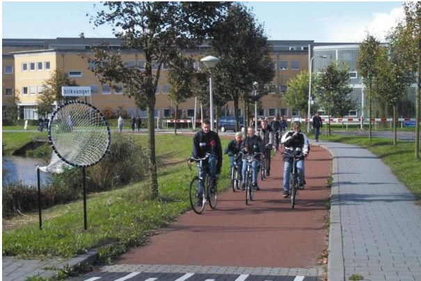
Foto 4.25 Vrijliggend fietspad met eigen verlichtingsinfrastructuur
